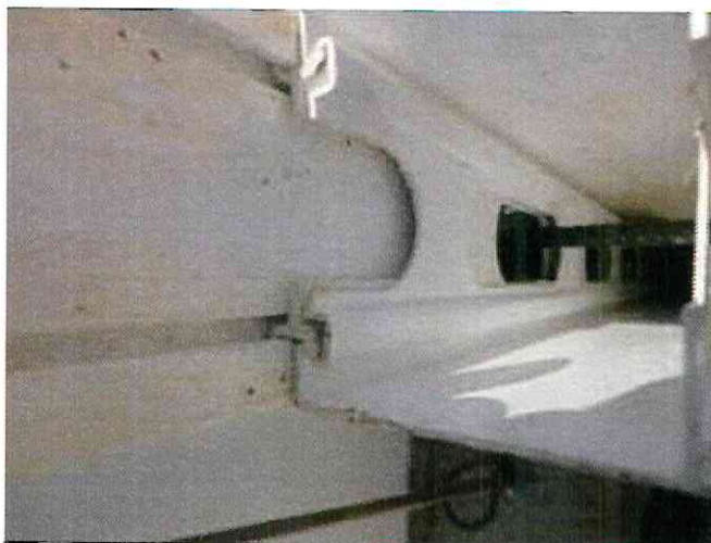
Figura 14 – Ferragem posicionada na região da contra-verga
