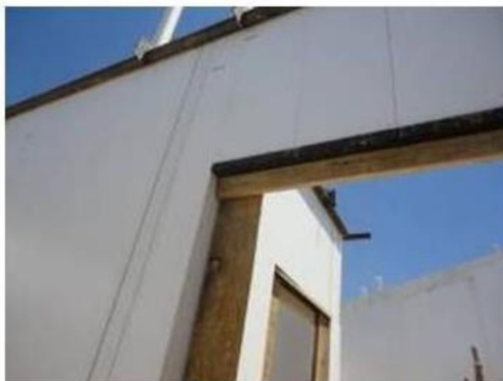
Figura 15 – Escoramento de aberturas de portas para concretagem
