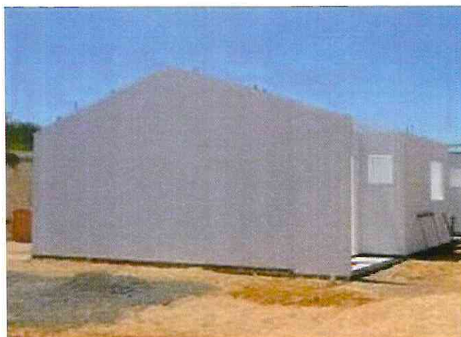
Figura 16 – Painéis de PVC concretados
