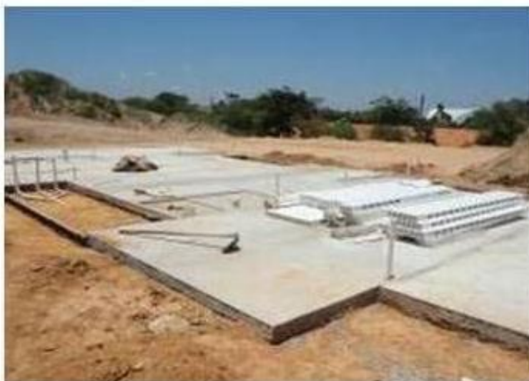
Figura 10 – Elemento de fundação com planicidade adequada
