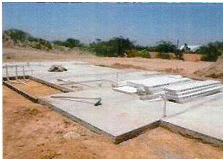
Figura 10 – Elemento de fundação com planicidade adequada
