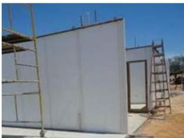
Figura 13 – Painéis de PVC posicionados e escorados
