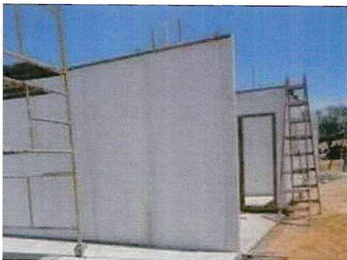
Figura 13 – Painéis de PVC posicionados e escorados
