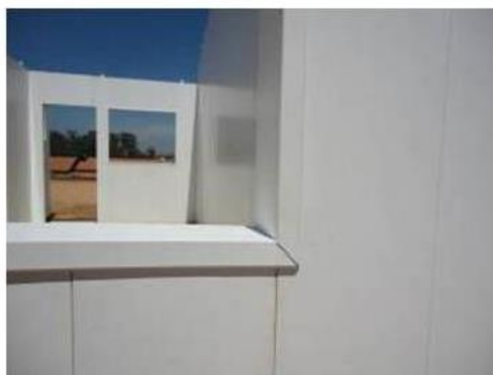
Figura 17 – Abertura das janelas com acabamentos em PVC
