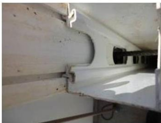
Figura 14 – Ferragem posicionada na região da contra-verga
