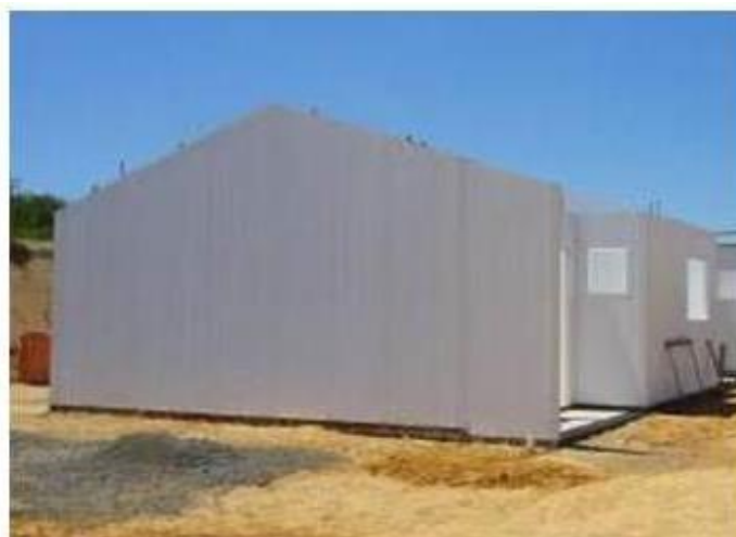
Figura 16 – Painéis de PVC concretados
