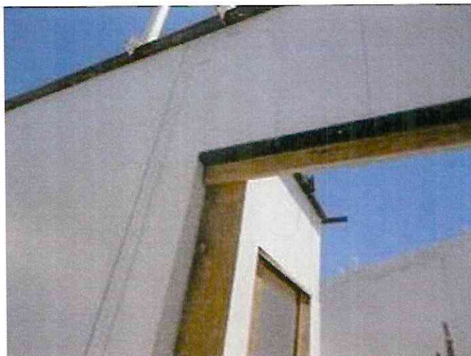
Figura 15 – Escoramento de aberturas de portas para concretagem
