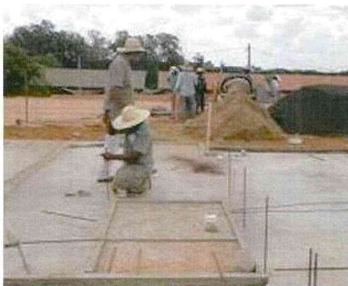
Figura 11 – Fixação das barras de ancoragem à fundação com adesivo epóxi
